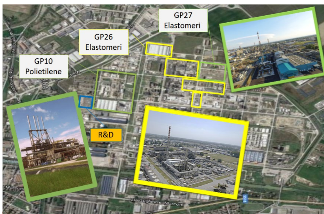
Figura 5: la posizione degli impianti Versalis nel sito.
