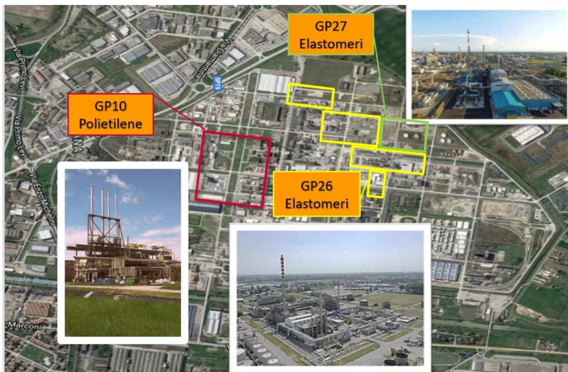
Figura 10: la posizione degli impianti Versalis nel sito
